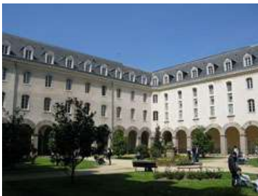
Bâtiment de la faculté d'économie de Rennes I (France). Crédit photo : XIIIfromTOKYO / CC BY-SA 3.0
